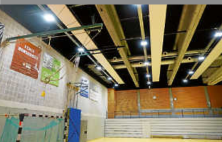
Fertigstellung der HES
