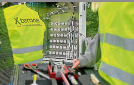
Ankündigung weiterer Glasfaser-Baustellen
