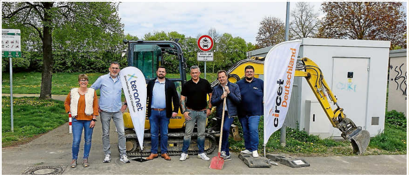
Sabine Kerner (Gemeinde Deizisau), Frank Kolmberger (Gemeinde Deizisau), Max Winterstein (Projektleiter GVG Glasfaser), Mario Hojer (Bereichsleitung Süd-West circet Deutschland), Bürgermeister Thomas Matrohs (Gemeinde Deizisau) und Marko Peric (Projektleiter circet Deutschland) Foto: Gemeinde Deizisau
