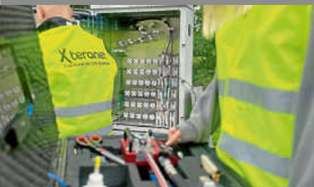
Glasfaserausbau in Deizisau
