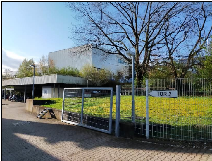
Abbildung 4: Südliches Gebäude Flst. Nr. 1599
