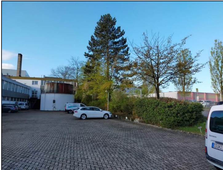
Abbildung 3: Nördliches Gebäude Flst. Nr. 1599
