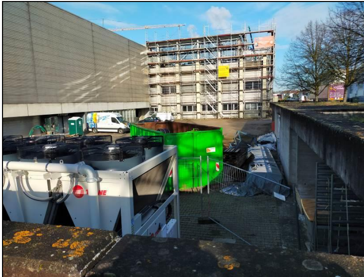
Abbildung 6: Vorhof des Gebäudes auf Flst. Nr. 1580
